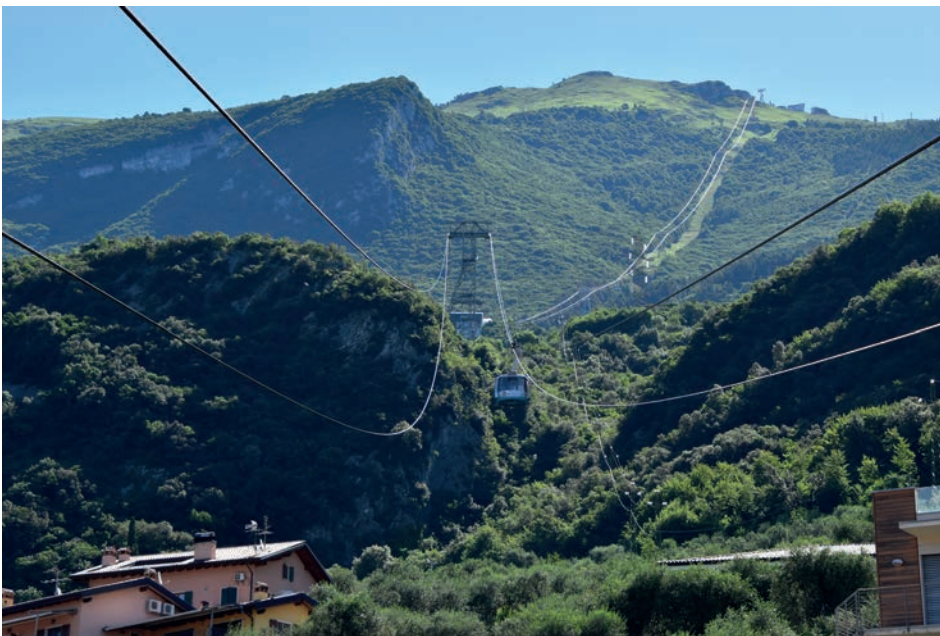
Obr. 21. Lanovka Malcesine – Monte Baldo vo svojom prvom úseku prekonáva prevýšenie takmer 500 m (a v druhom až 1 187 m)
